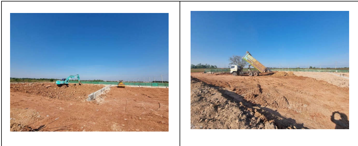
รูปถ่ายที่ 3.2-9 : การปรับถมดินภายในพื้นที่โครงการ
